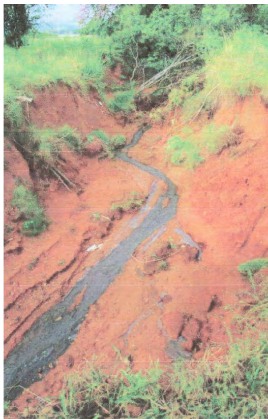
Figura 17 - erosão e vazamento de emissário de esgoto na saída da galeria.
