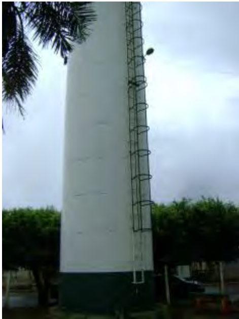
Figura 6- reservatório elevado do S-01
