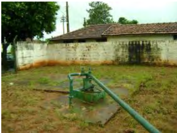
Figura 8- poço do S-01
