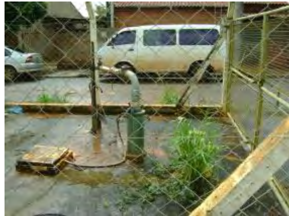
Figura 21- Poço ativo do S-02
