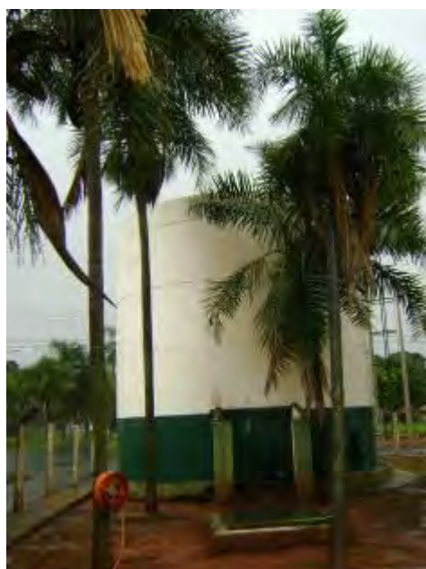
Figura 4- Reservatório apoiado do S-01
