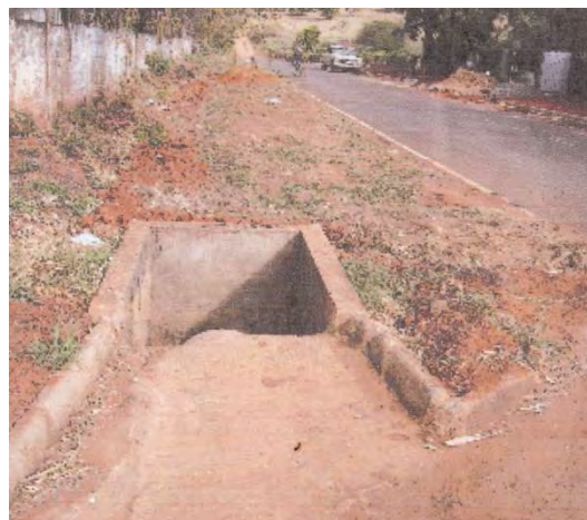
Figura 25 - equipamento de drenagem da Rua Campos Salles.
