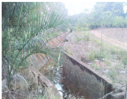
Figura 20 – canal a céu aberto de dissipação de águas pluviais da Rua 5.
