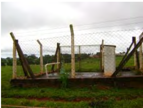
Figura 15- Poço do S-01 na estrada vicinal
