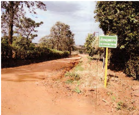
Figura 22 – vista da estrada vicinal, corredor natural de drenagem da área 3.
