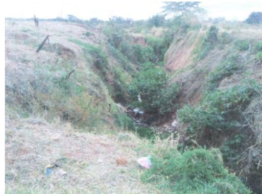
Figura 12 - lançamento de galeria Área 1
