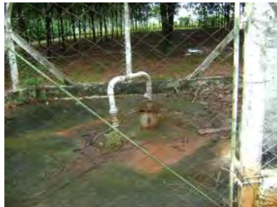
Figura 18- Poço do S-01 na Rod. Jamil Chamas
