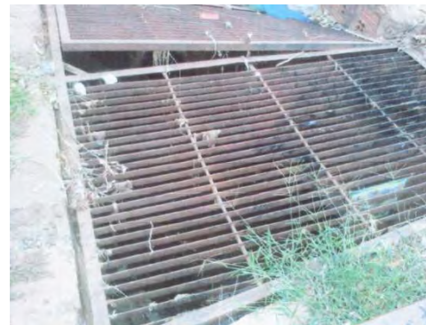
Figura 8 – Equipamento de drenagem da área 1.
