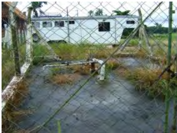
Figura 17- Poço do S-01 na Rod. Jamil Chamas
