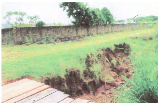
Figura 16 – erosão na saída da galeria.
