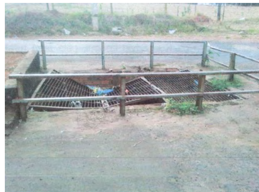
Figura 10 – Equipamento de drenagem da área 1.
