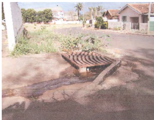
Figura 24 – equipamento de drenagem da Rua Campos Salles.
