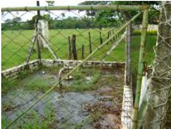
Figura 13- Poço do S-01 na estrada vicinal
