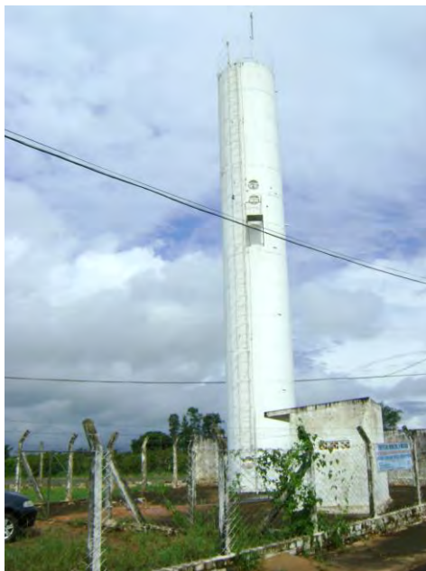
Figura 33- Reservatório do S-05
