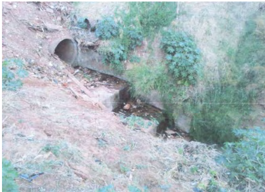
Figura 11 – lançamento de galeria Área 1
