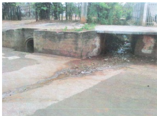
Figura 19 – equipamento de drenagem da Rua 5.
