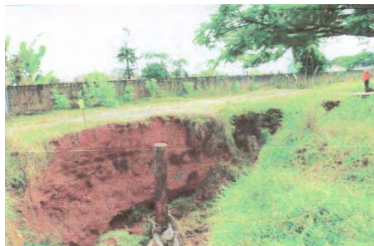
Figura 15 – erosão na saída da galeria.
