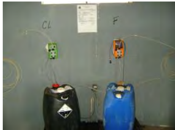
Figura 9- Sala de cloração e fluoração
