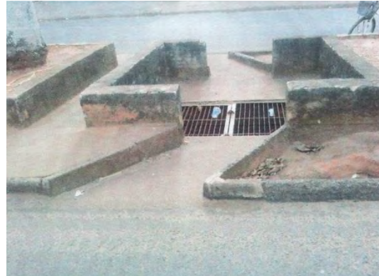
Figura 6 – Equipamento de drenagem da área 1.
