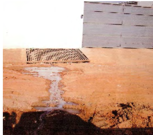
Figura 23 – equipamento de drenagem da área 3.
