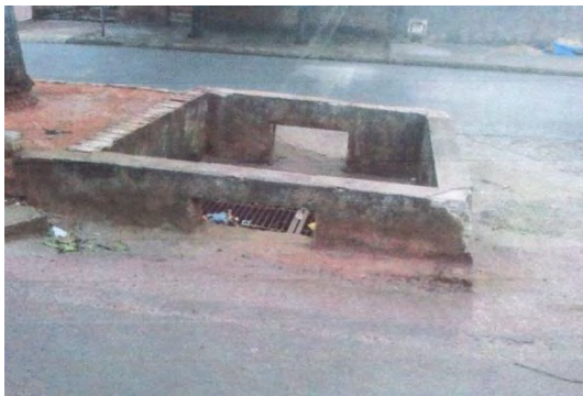
Figura 7 – Equipamento de drenagem da área 1.
