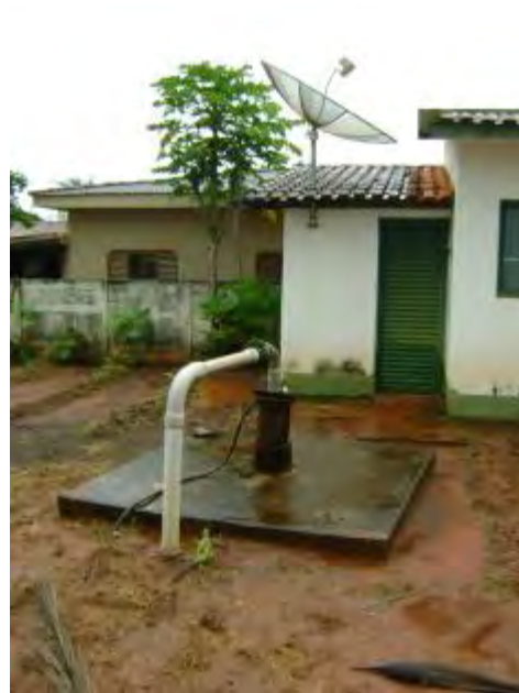
Figura 7- Poço do S-01
