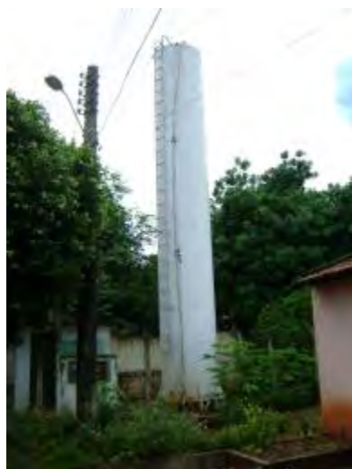
Figura 27- reservatório elevado do S-03
