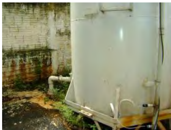
Figura 26- Detalhe do poço do S-03
