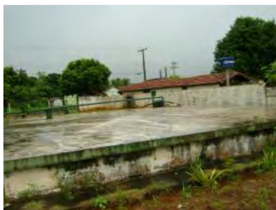
Figura 5- Reservatório semienterrado do S-01
