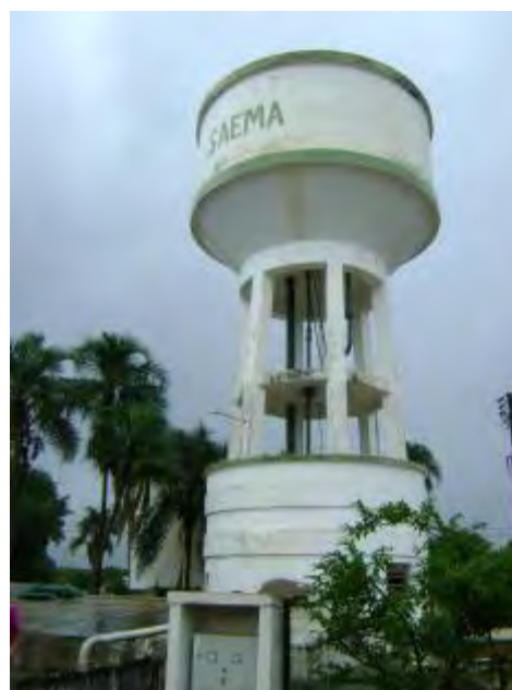
Figura 3- Reservatório elevado de concreto do S-01
