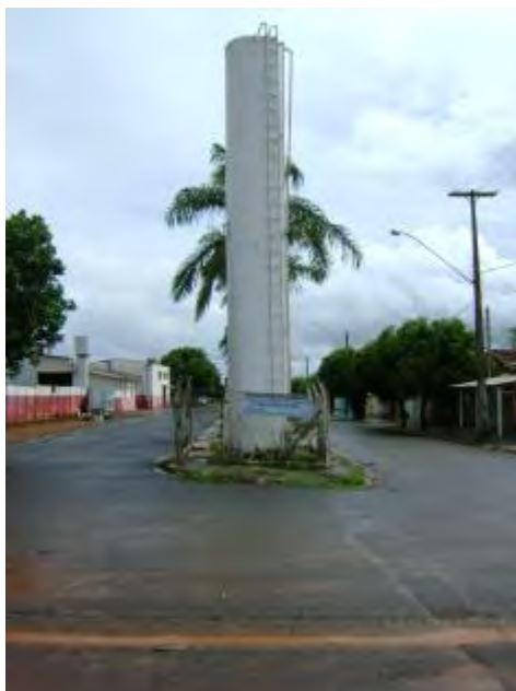
Figura 22- Reservatório elevado do S-02
