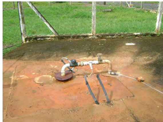
Figura 32- Poço do S-05
