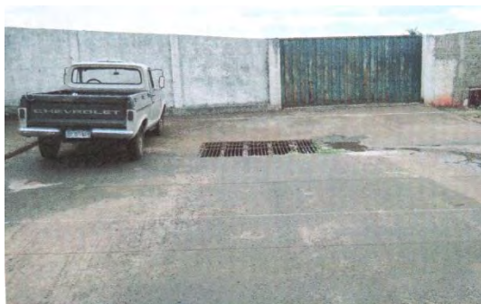
Figura 14 – equipamento de drenagem da área 2.
