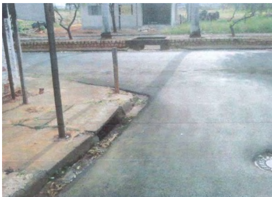
Figura 9 – Equipamento de drenagem da área 1.
