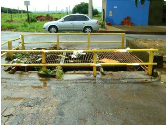
Figura 5 – Equipamento de drenagem da área 1.
